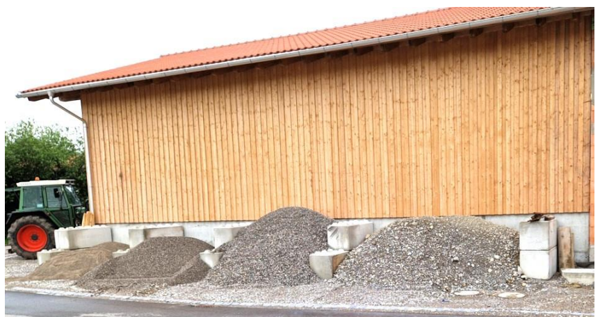
Boxen für Sand und Kies beim neuen Bauhof
