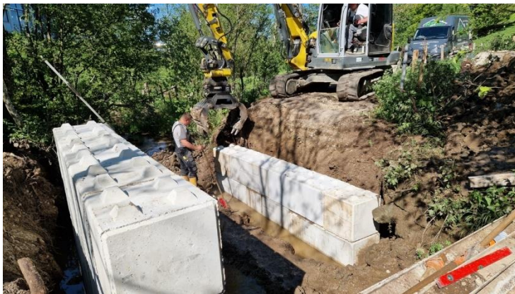
Brückenbau bei TBA
